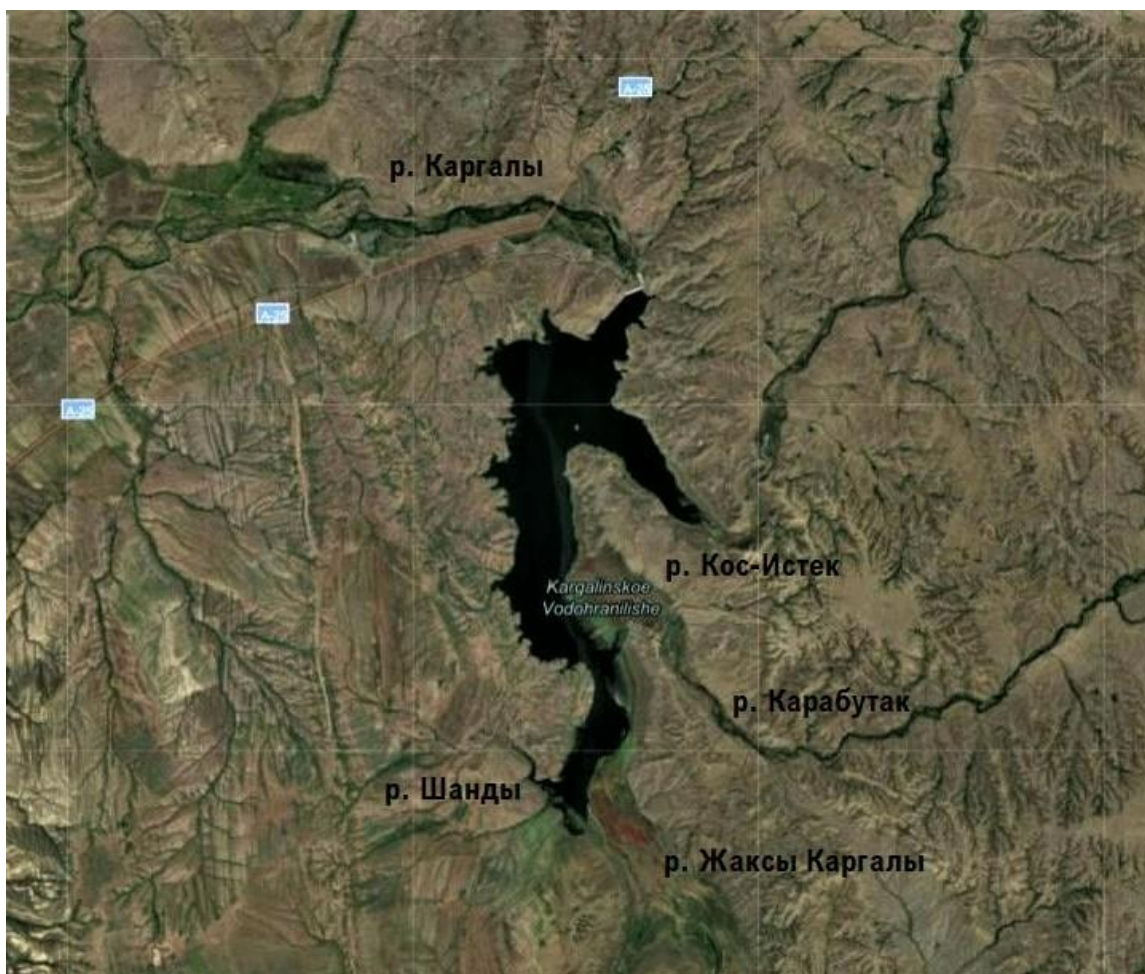
Рис. 1 – Каргалинское водохранилище (вид со спутника)
