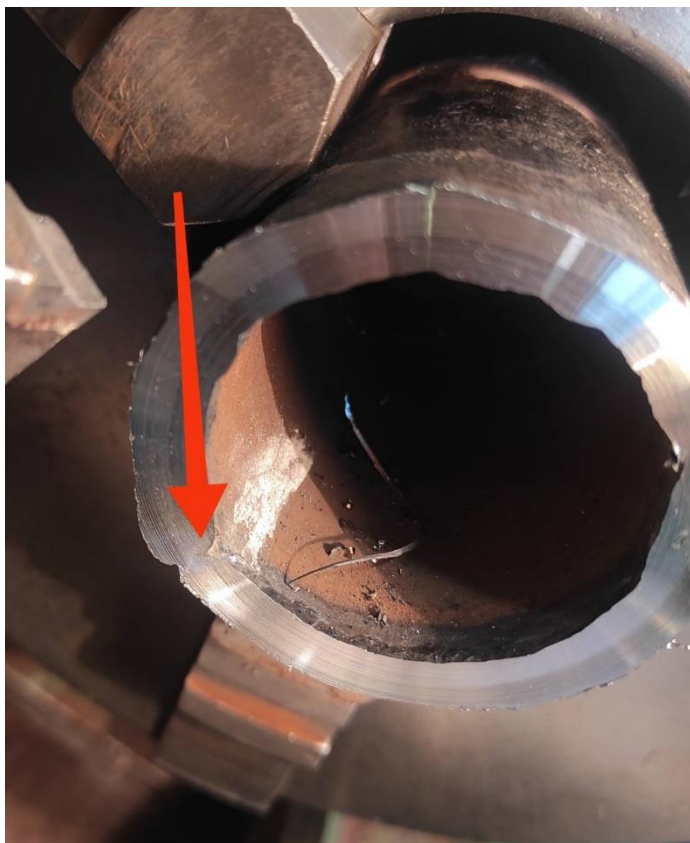
Рисунок 2.1. – Выборка на станке. Сканирование с помощью наклонного ПЭП раздельно-совмещенного типа. Непровар в корне и утяжина на усилении шва. Плоскостной дефект
